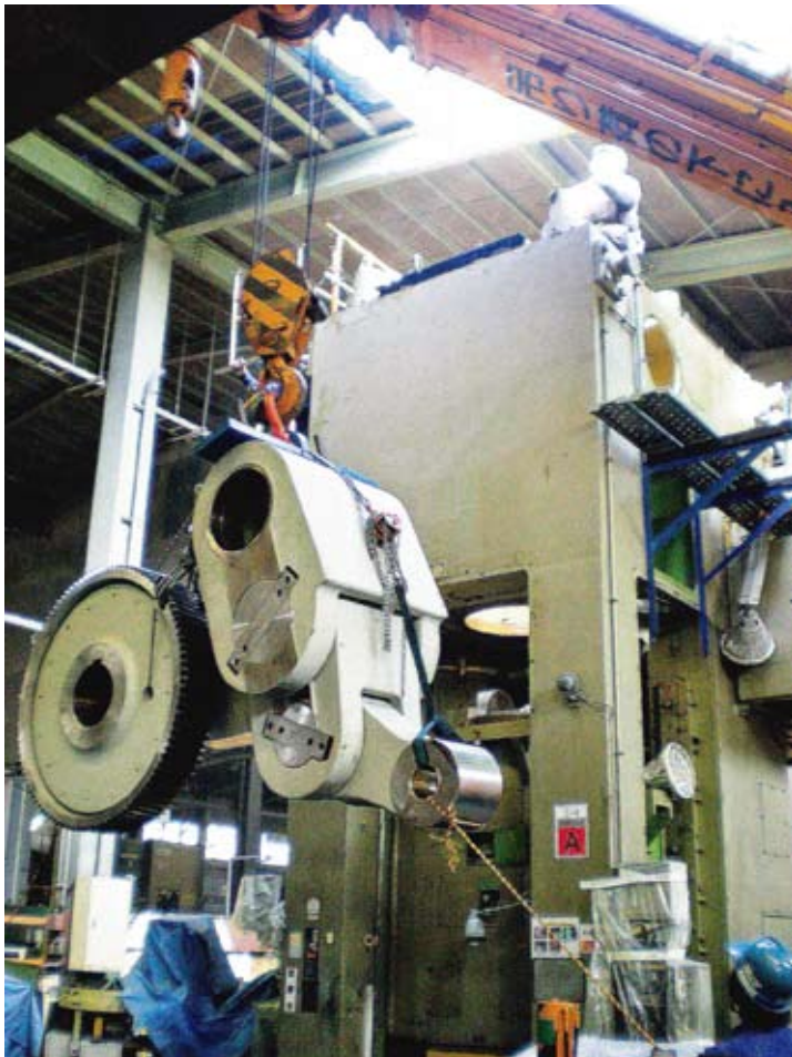
駆動部及びメタル組付け工事
