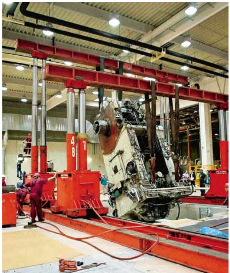
海外移設工事
