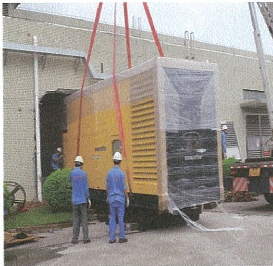
(3) 発電機を設置する 吊起发电机并移位
