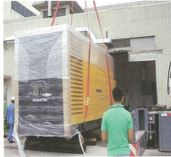
(4) 発電機を設置する 吊起发电机并移位
