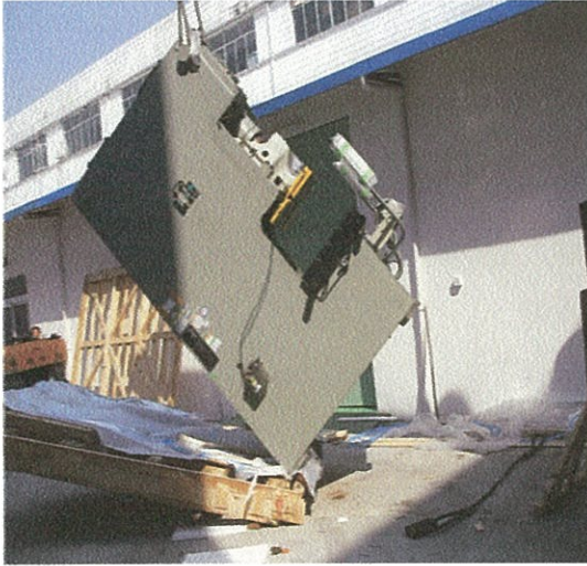
(1) プレスを吊上げ 吊起冲压机
