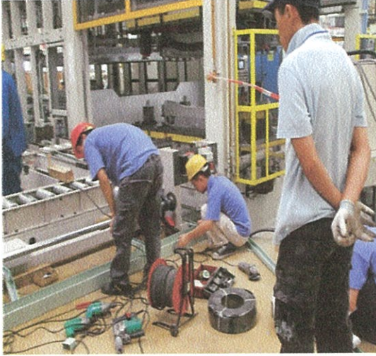
(1) 配線ラックを付ける 安装电线槽
