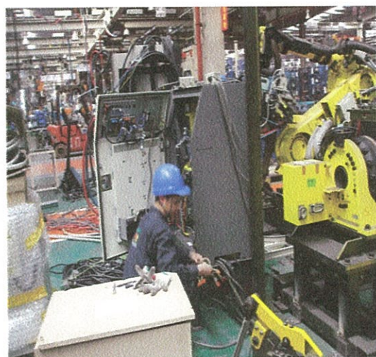
(3) 配線を外す 拆除电线
