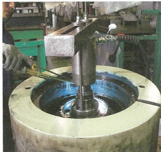
(4) シャフトをバラス 用气焊对轴进行拆卸
