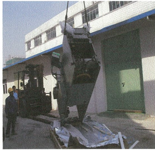
(2) プレスを吊上げ 吊起冲压机
