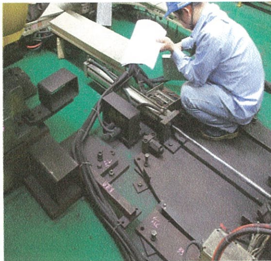
(2) 配線端子番号を確認する 确认电气配电箱端子符号
