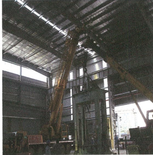
(2) 重機を二台同時使う 两台起重机同时起吊
